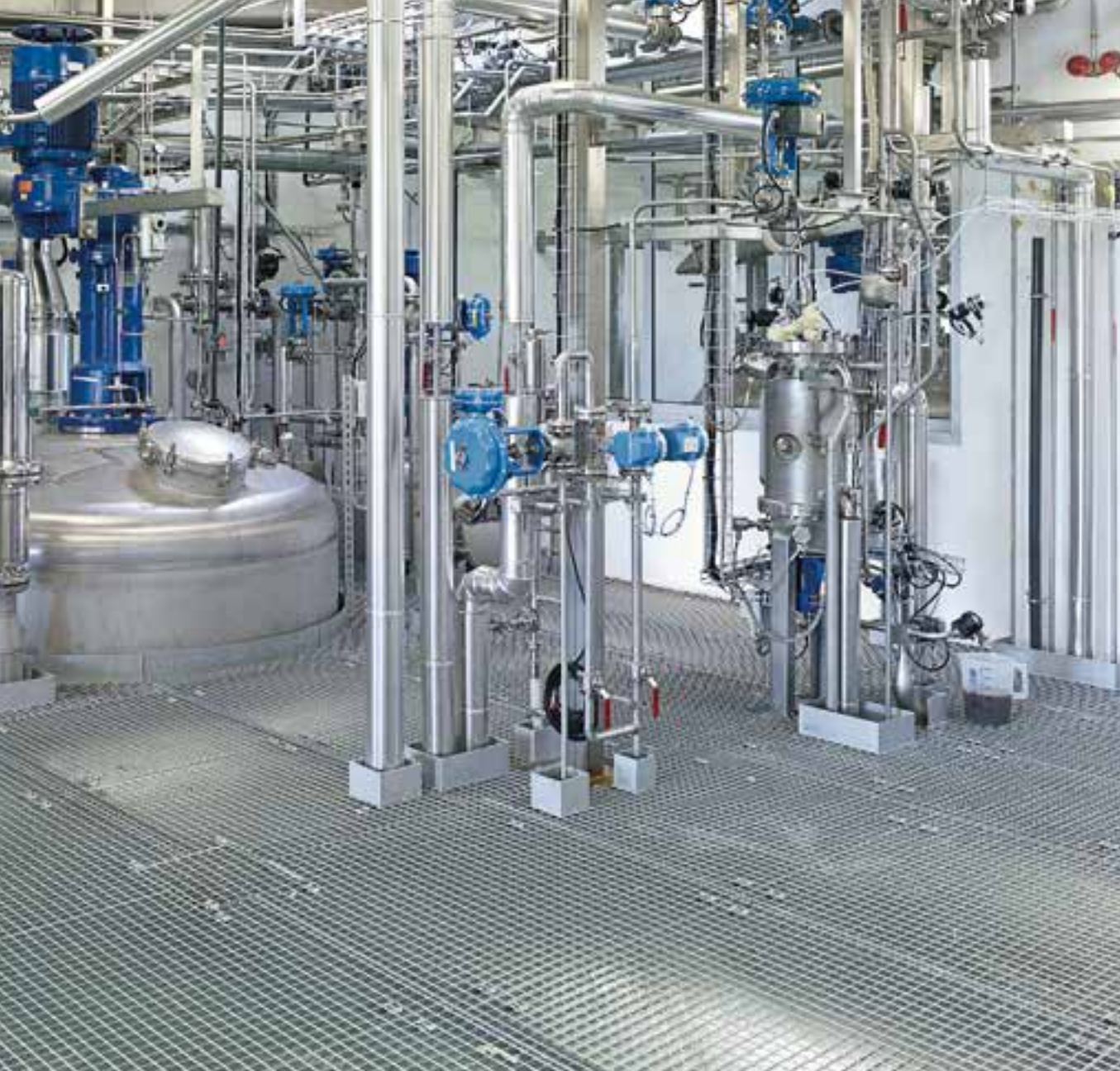
БИОЭТАНОЛ ЗАВОД, ШТРАУБИНГ
